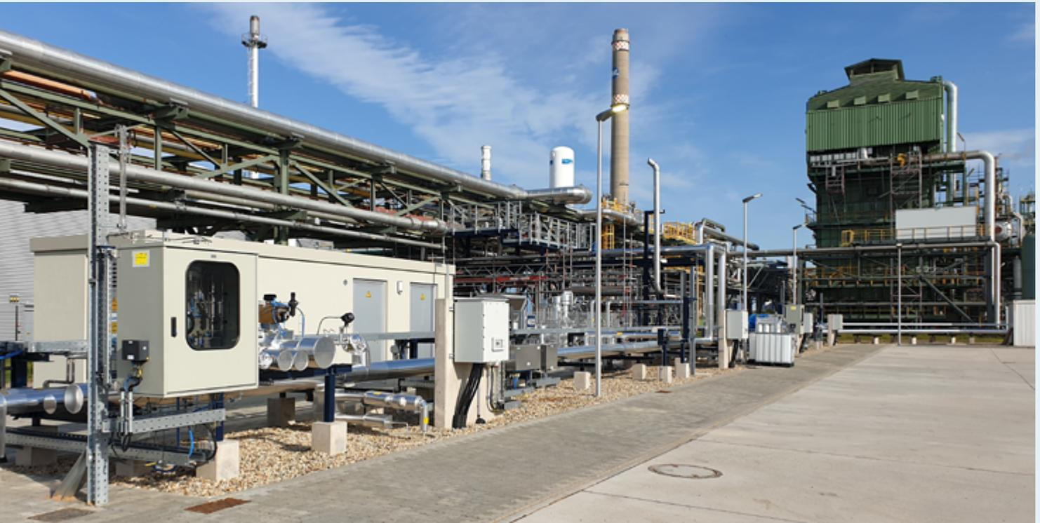
*Auf den Außenflächen des Hydrogen Lab Leuna können Elektrolyseure und PtX-Pilotanlagen mit direktem Anschluß an dem Stoffverbund der chemischen Industrie getestet werden.*
