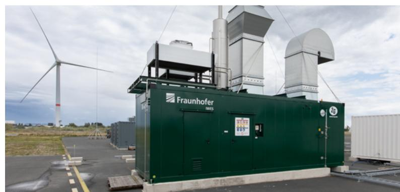
Wasserstoff-BHKW auf einer Prüffläche des HLB, im Hintergrund: die Offshore-Prototyp-Windenergieanlage AD8-180
